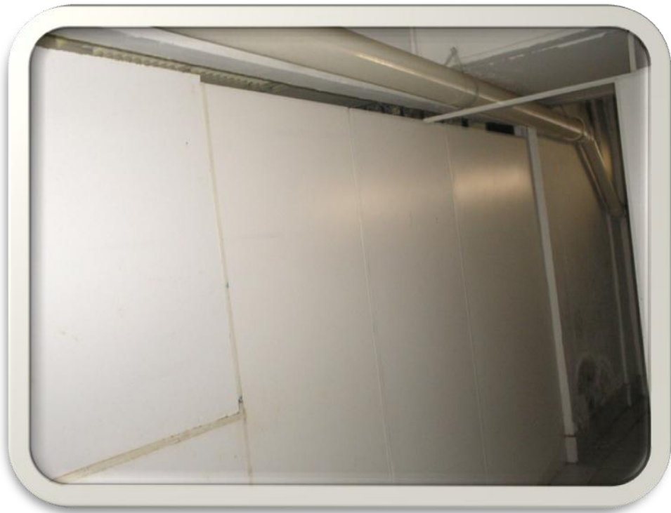
Figura 11. Sala de estoque 2 - Catequese-Subsolo
