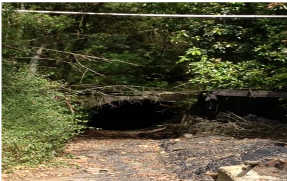
FOTOGRAFIA 2 – Antiga entrada de mina subterrânea abandonada
