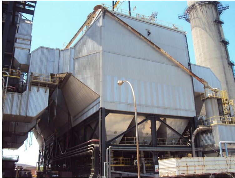
Figura 25 – Precipitadores eletrostáticos
