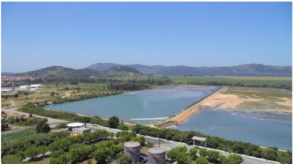
Figura 26 – Bacias de decantação das cinzas pesadas
